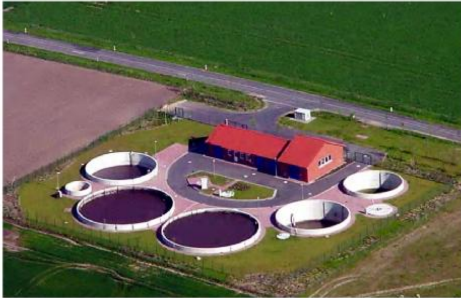
SBR plant for 10000 PE
