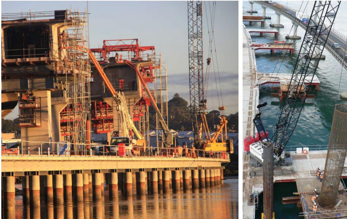
الشكل (1) ويظهر الأطراف الممتدة للرصيف البحري الصناعي, وهو مجهزة بروافع.
