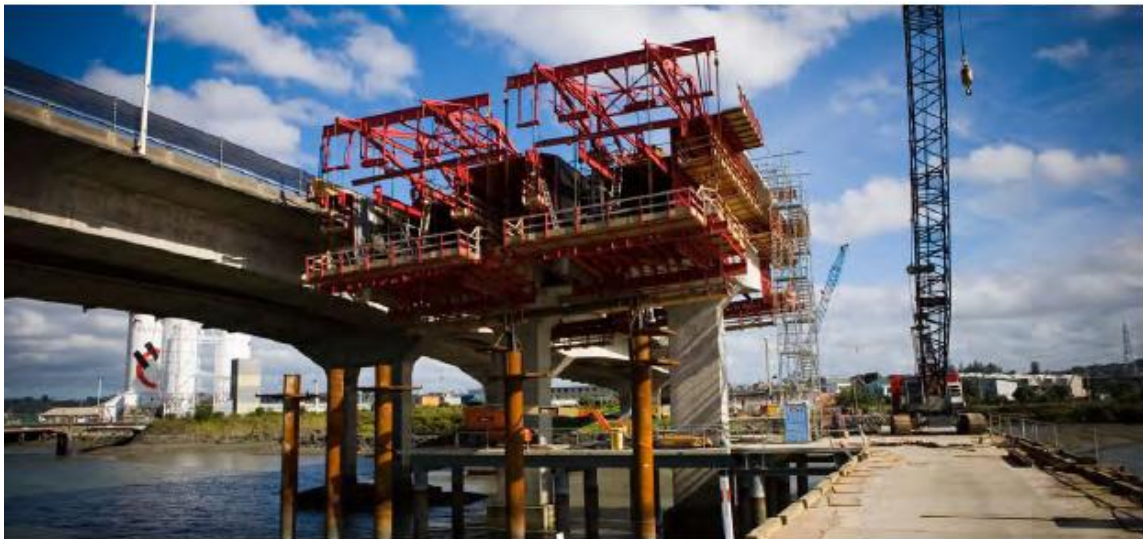
الشكل رقم (4) مراحل نصب الأوتاد كركائز للجسور وصورة لجسر منفذ بهذه التقنية في مطار Harbour.
