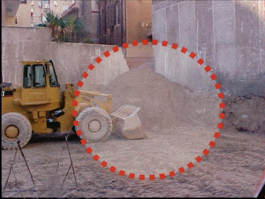
إستخدام اللودر في اعمال تسوية الأرض
