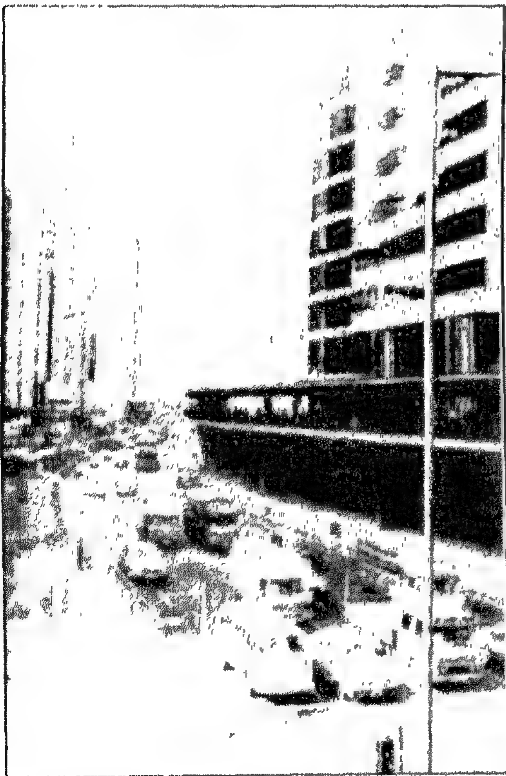
مبنى ام السجادة في مدينة دبي
